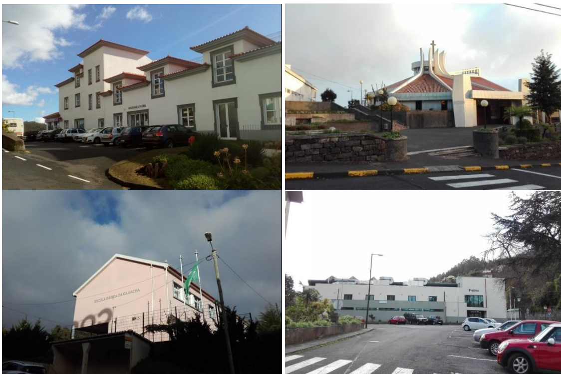
Figura 17. Segurança Social da Camacha (em cima esq.); Igreja Paroquial da Camacha (em cima drt.) Escola Básica (em baixo esq.); Piscina (em baixo drt.)
