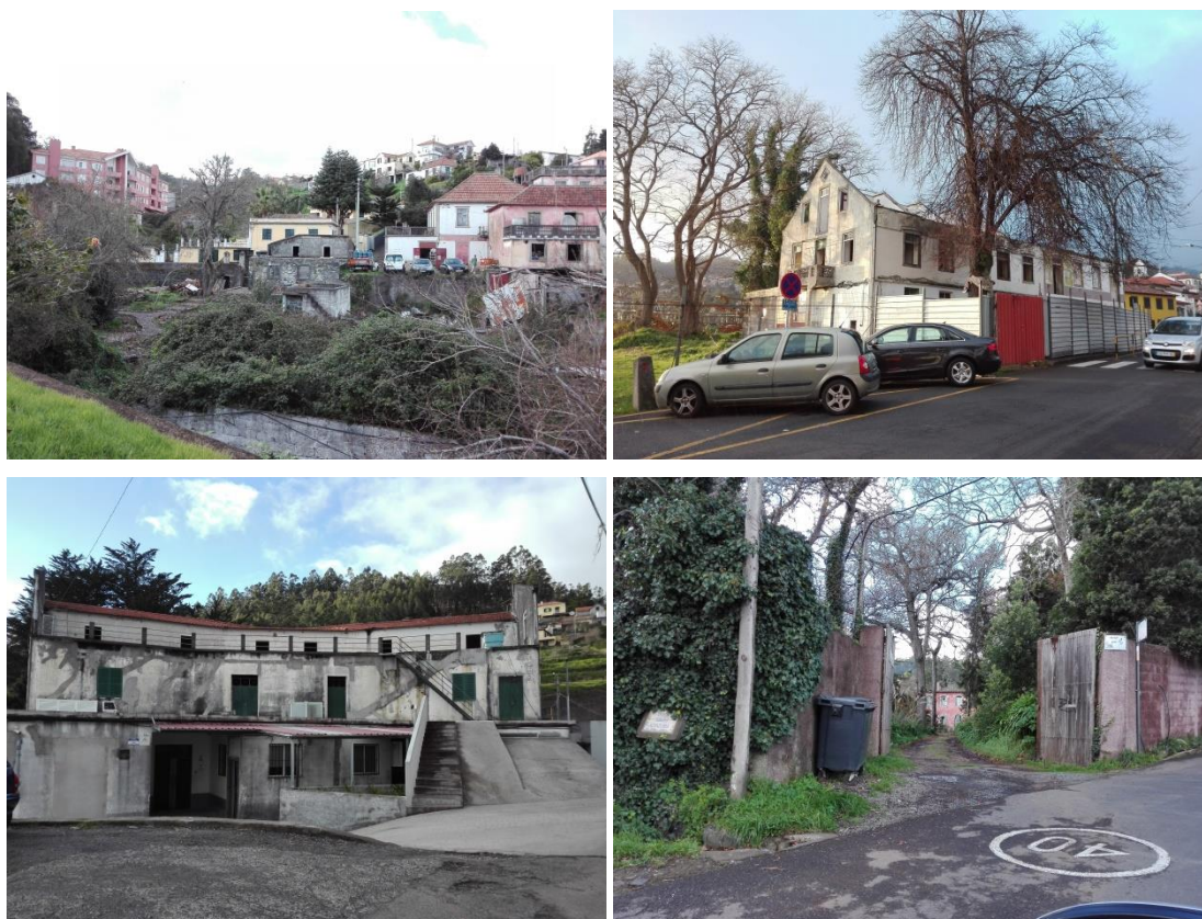
Figura 23. Situações de degradação, insuficiência ou obsolescência. Fonte: SPI, 2018/2019
